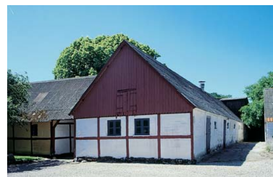
Hærvejen 13, Højerup. De kalkede tavl er muret af kridtsten, som er rejst på fladen. Bindingsværket står direkte på tjerede syldsten. Gavlen har malet bindingsværk, hvorimod der på facaden er det for Sjælland karakteristiske, overkalkede bindingsværk.
