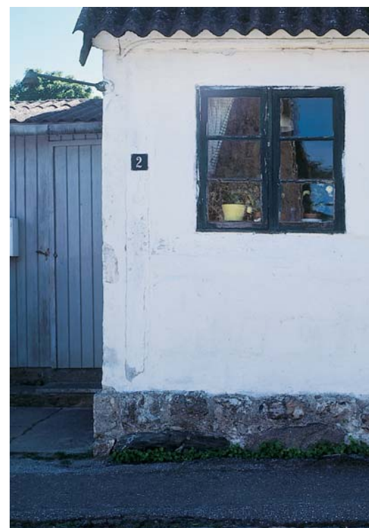
Højerupvej 2, Højerup. Detaljens harmoni. Her opleves det ædle håndværk, når det er bedst: Kampestenssoklen, den meget stoflige bindingsværksfacade, det lille, næsten kvadratiske vindue med indkittede ruder og øverst et vindbræt under de nyere bølgeeternitplader.
