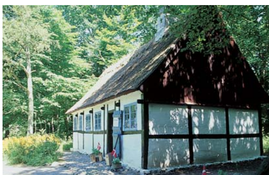
Fiskerhuset ved Gl. Højerup Kirke. Seks fag i længden og tre fag i bredden, et 1700-tals modulbyggeri. En lille bygning der har mange fine detaljer, gennemstukne bjælker, todelt revledør, en bræddegavl med vandbræt - og selvfølgelig tavl opmuret med kridtsten.
