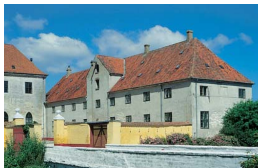
Gjorslev. I 1638 blev en nordlig fløj opført som en mindre kridtstensbygning i to stokværk. Den blev med undtagelse af kælderen ombygget i 1700-tallet.
