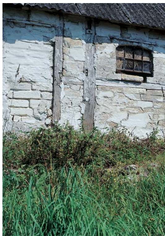
Gård ved Klokkervej i Lille Heddinge. Facadeudsnittet viser tydeligt, hvordan en af tavlene er muret af kridtsten på kant. En stenbesparende byggemåde, men teknisk uheldig, fordi kridtets lagdeling vender lodret.
