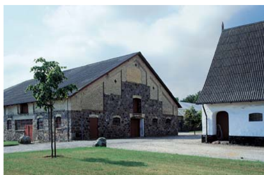
Den sydøstlige kalvestald er opført i grov granit og mursten og fremstår meget velbevaret.
