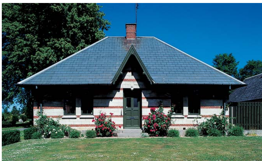
Graverboligens gennemførte materialevalg og detaljering giver en stemning af disciplineret diskretion.
