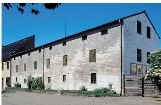
Pakhus, som har tilhørt Chr. Richters købmandsgård. Den enkle bygning fremstår i et klart kridtstensvolumen. Vinduernes uprægtiøse størrelse og placering understreger bygningens funktion og enkelhed.
