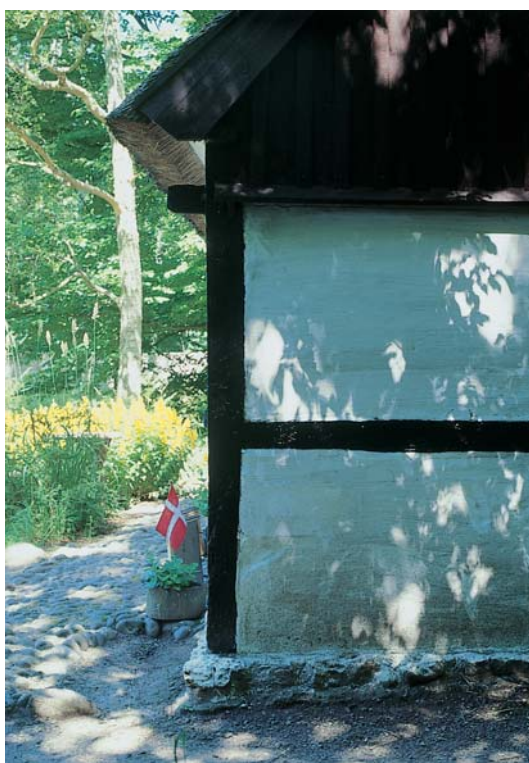
Fiskerhuset ved Gl. Højerup Kirke. Afstanden fra syldsten til løsholt og fra løsholt til toprem er bestemt af kridtstenenes tykkelse. Her er den nederste tavl syv sten høj.
