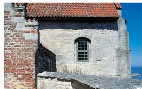
Højerup gamle kirke, sydfacaden. Den tidligste brug af kridtsten er præget af sten med forskellig størrelse, så skiftehøjderne springer. De største sten blev anvendt til hjørnekvadre.
