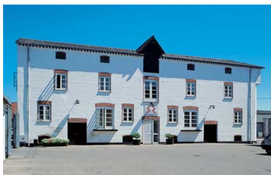
Pakhus ved Chr. Richters købmandsgård i Store Heddinge. Pakhuset er bygget som et grundmuret hus i kridtsten. Stik over vinduer og døre samt vinduesfalsene er dekorativt muret af røde teglsten.
