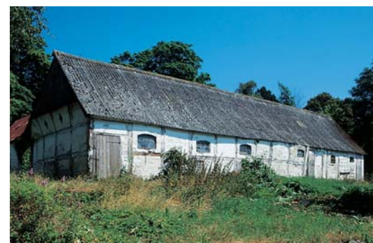
Gård ved Klokkervej i Lille Heddinge. Manglende vedligeholdelse og teknisk forfald giver maleriske oplevelser. Avlsbygningen er et pragt-eksemplar på bindingsværk med kridtstenstavl. Bemærk de fine revledøre og støbejernsvinduerne.
