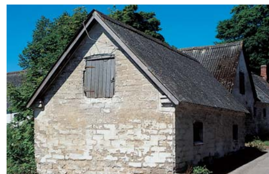
Gård ved Klokkervej i Lille Heddinge. Bygningen savner kalk, men det forbedrer muligheden for at se, hvordan denne lille avlsbygning er muret. Bemærk stikket over lemme og gesimsen, der lige 'fanger' gavlen.
