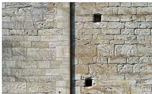
Skt. Katharina Kirke. I trækronernes skyggespil på den hvide facade ses små rektangulære huller - bomhuller fordelt systematisk over facaden. Bomhullerne anvendtes i forbindelse med opsætning af stillads.
