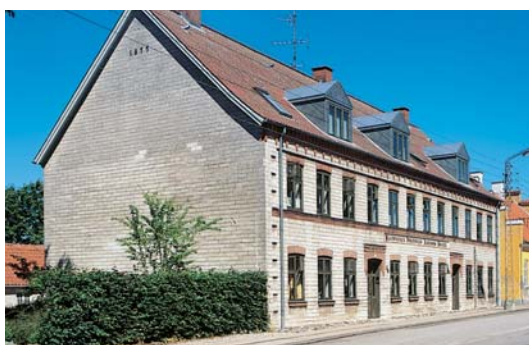
Nørregade 13, Store Heddinge. Håndværkerforeningens aldersbolig, opført i 1877, er en meget betydelig kridtstensbygning, hvor der er anvendt røde teglsten til dekorative formål.
