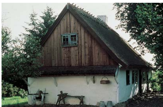
Tåstrupvej 33. 'Trines hus' er opført omkring 1770. Det er opført af bindingsværk og fremstår i dag, i overensstemmelse med den stevnske byggeskik, med overkalket bindingsværk. En gang i 1800-tallet blev sydmurens lerklinede tavl udskiftet med tavl af kridtsten. Bygningen blev fredet i 1983.
