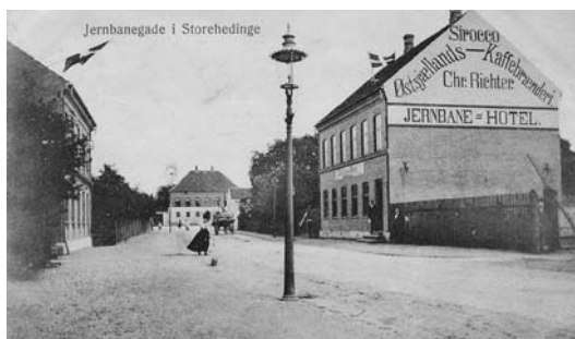
I 1879 blev Østjællandske Jernbane oprettet. Store Heddinge station blev placeret vest for byen. For at forbinde byen og stationen anlagde jernbanselskabet Jernbane Allé fra Vestergade, mens byen påtog sig at anlægge Jernbanegade og dermed forbindelsen til Nytorv. Billedet er fra 1910. (Stevns lokalhistoriske arkiv).
