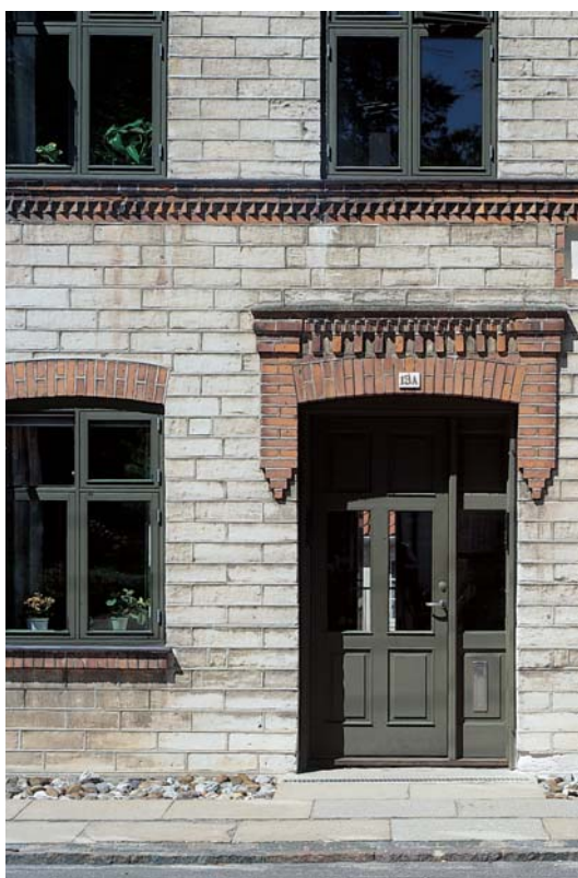
Nørregade 13, Store Heddinge. Facadeudsnittet viser en detaljerigdom skabt ved at kombinere den hvide kridtsten med røde teglstensdetaljer. Bemærk den fine portal med murede draperier og gesimsen med buefrise.
