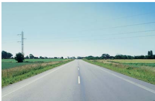
Rødvigvej. En moderne, udnivelleret vej med midterstribe, som understreger rationalitet og fart.
